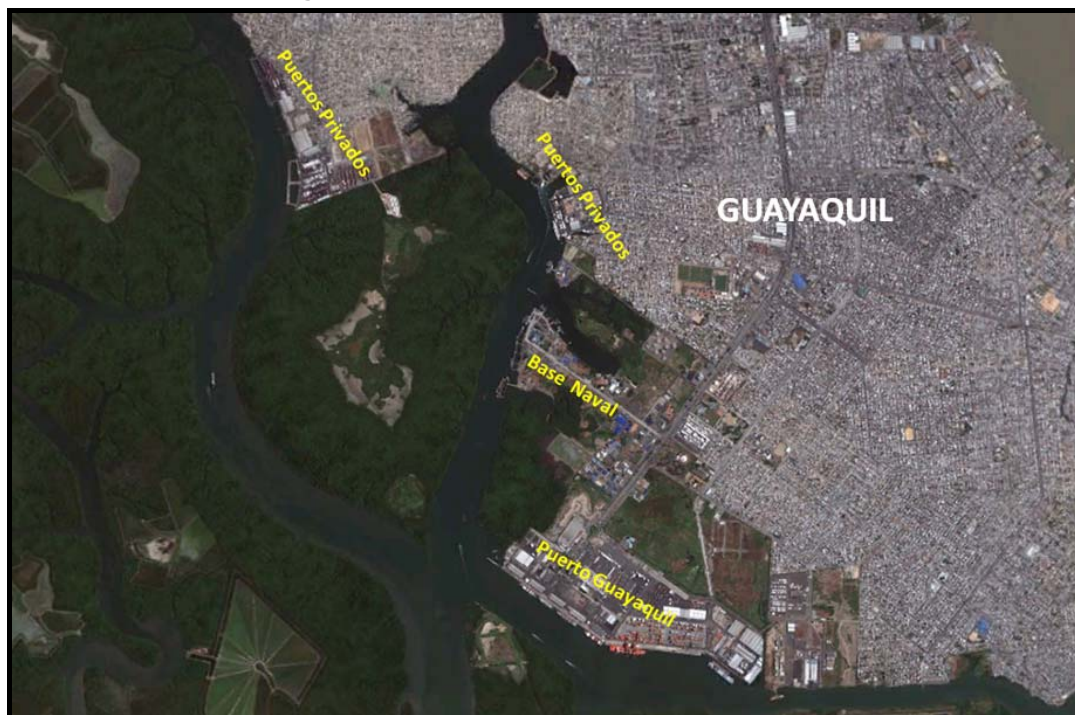
Figura 12. Terminal Cabecera Canal de Acceso
