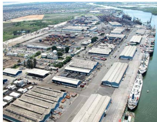
Fotografía 2. Construcción de los Muelles 2000
