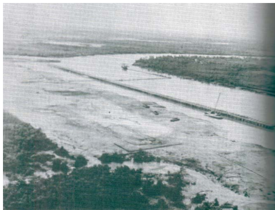
Fotografía 1. Construcción de los Muelles 1960
