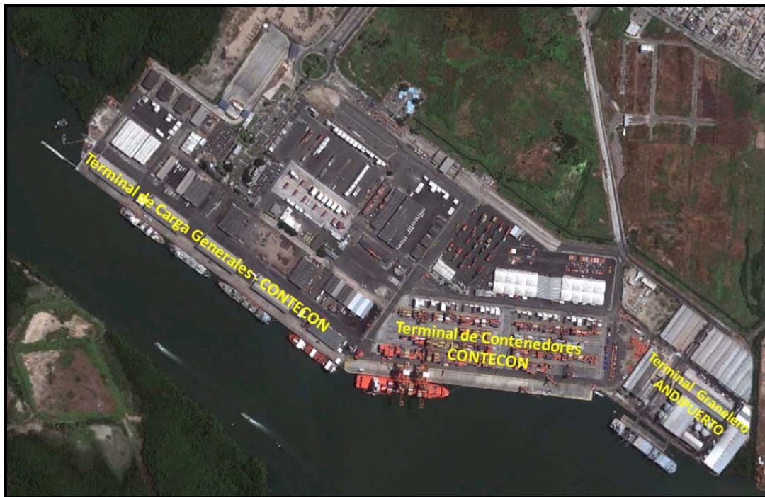
Figura 11. Terminales de APG
