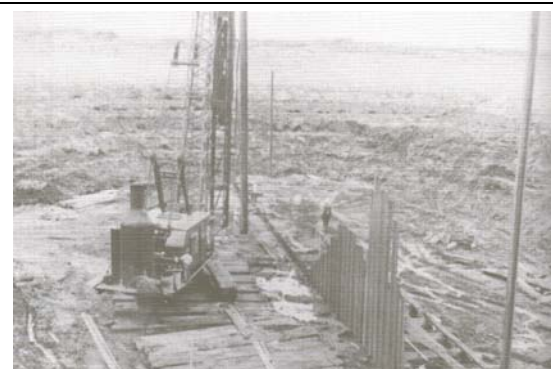
Fotografía 3. Tablestacado para las Esclusas 1961
